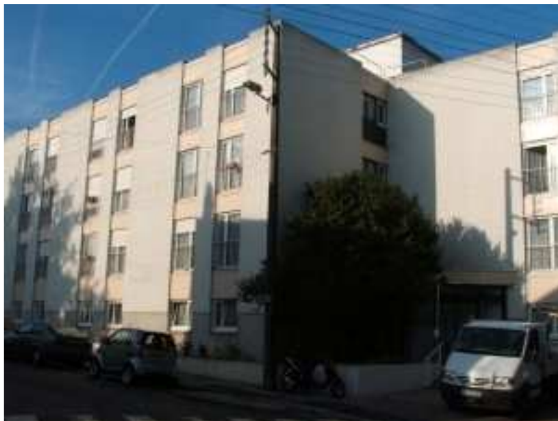
La Maison de la Chézine après la dernière rénovation
